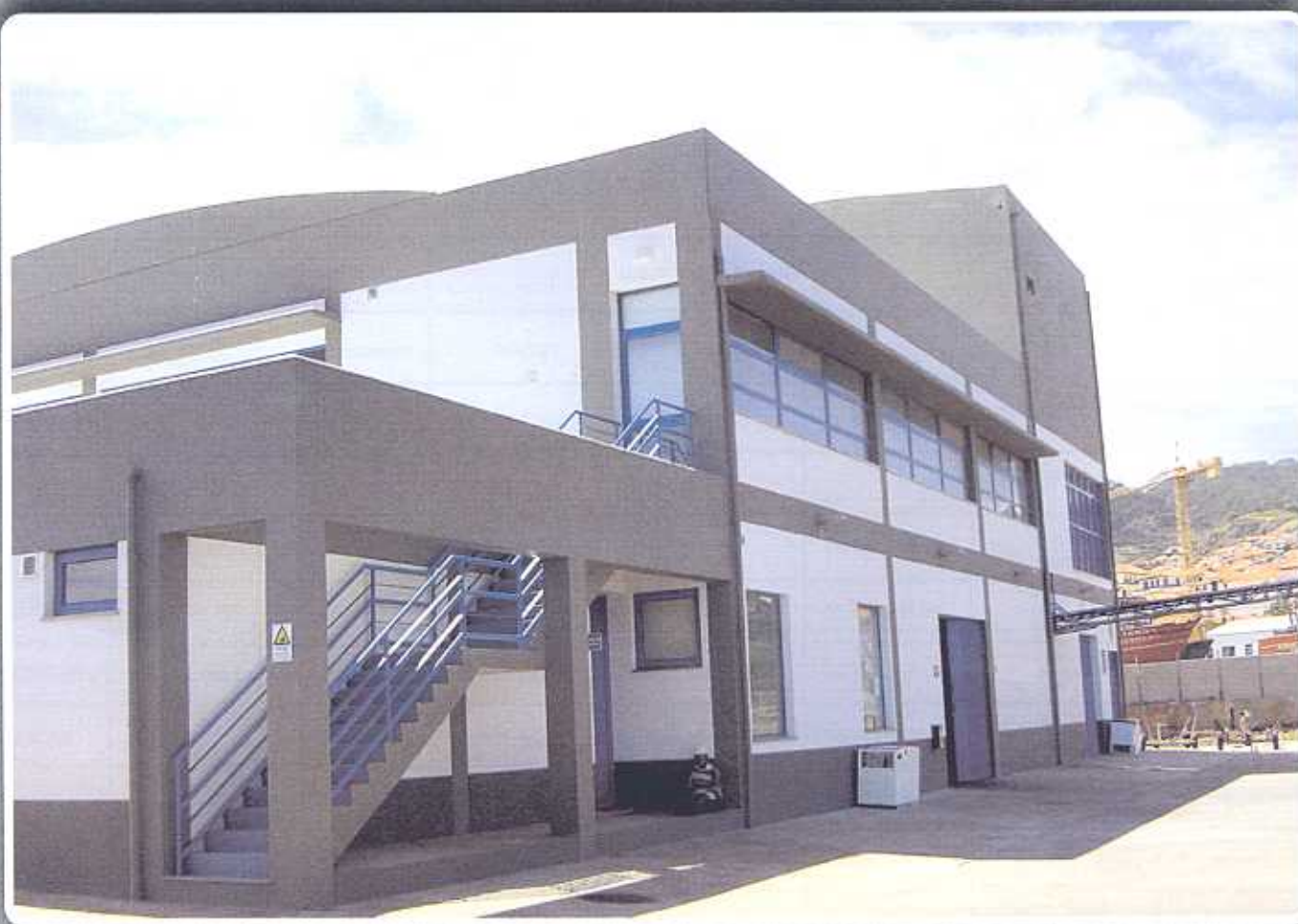
“Construção da Lota do Caniçal”
