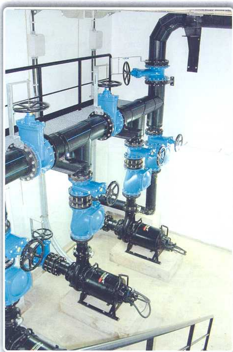
“Remodelação da rede de drenagem e tratamento das águas residuais da Ilha do Porto Santo”
